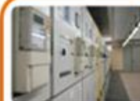
Шкафы КРУ 35/20/6(10) кВ
